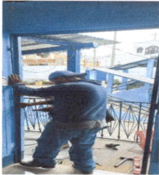
Foto1: Sustitución de puerta en dirección
