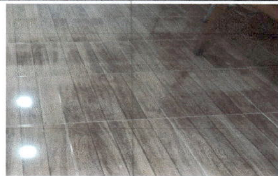
Foto 6: Sustitución de piso ceramico en cocina.
