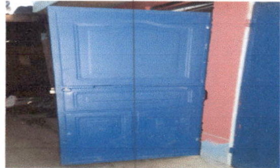
Foto 2: Sustitución de puerta en servicio sanitario.
