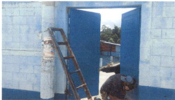
Foto 3: Sustitución de portón en entrada principal.
