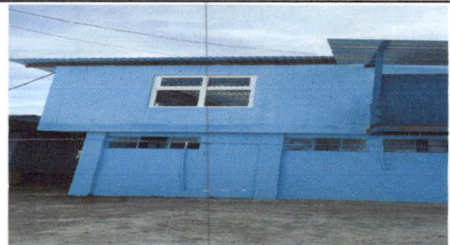
Foto 4: Sustitución de estructuras de metal de ventana a pvc en aula.
