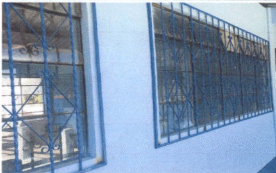
Foto 5: Sustitución de balcones en aula.
