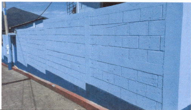
Foto7: Pintura de muro exteriores en entrada principal.
