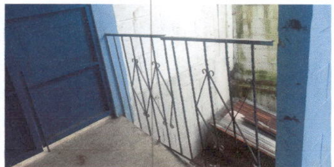
Foto 10: Sustitución de barandas de metal en entrada principal
