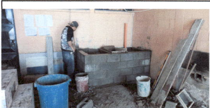
Foto13: Sustitución de pila de dos lavaderos en cocina.
