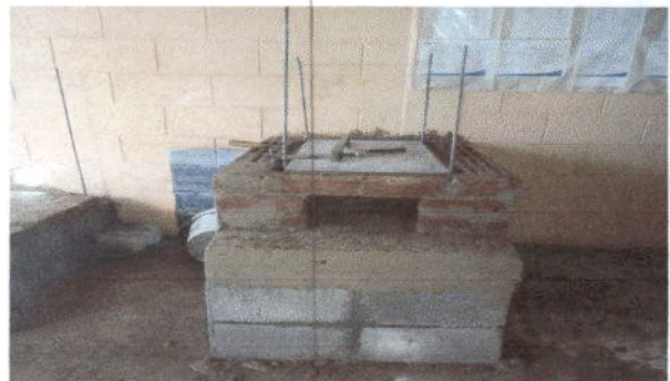
Foto 12: Sustitución de estufa rural completa incluyendo chimenea y plancha de metal en cocina.
