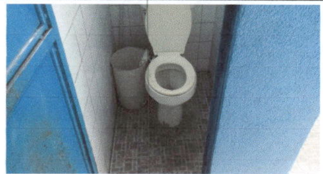
Foto 8: Sustitución de inodoros y sus accesorios
